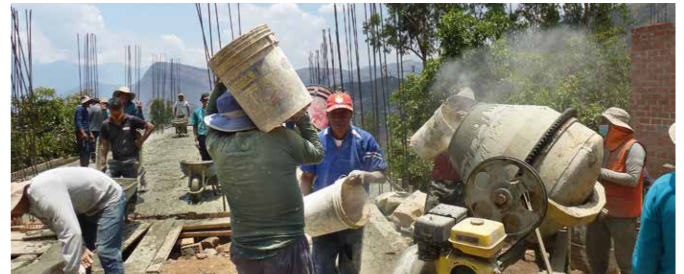
Bau des neuen Gemeindehauses im Dorf Umaca
